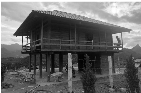
Hình ảnh nhà sàn từ tre ép khối ở Lai châu (Việt Nam). Sản phẩm của đề tài cấp Nhà nước: “Nghiên cứu công nghệ sản xuất tre ép khối làm vật liệu xây dựng và nội thất tại vùng Tây Bắc”.
